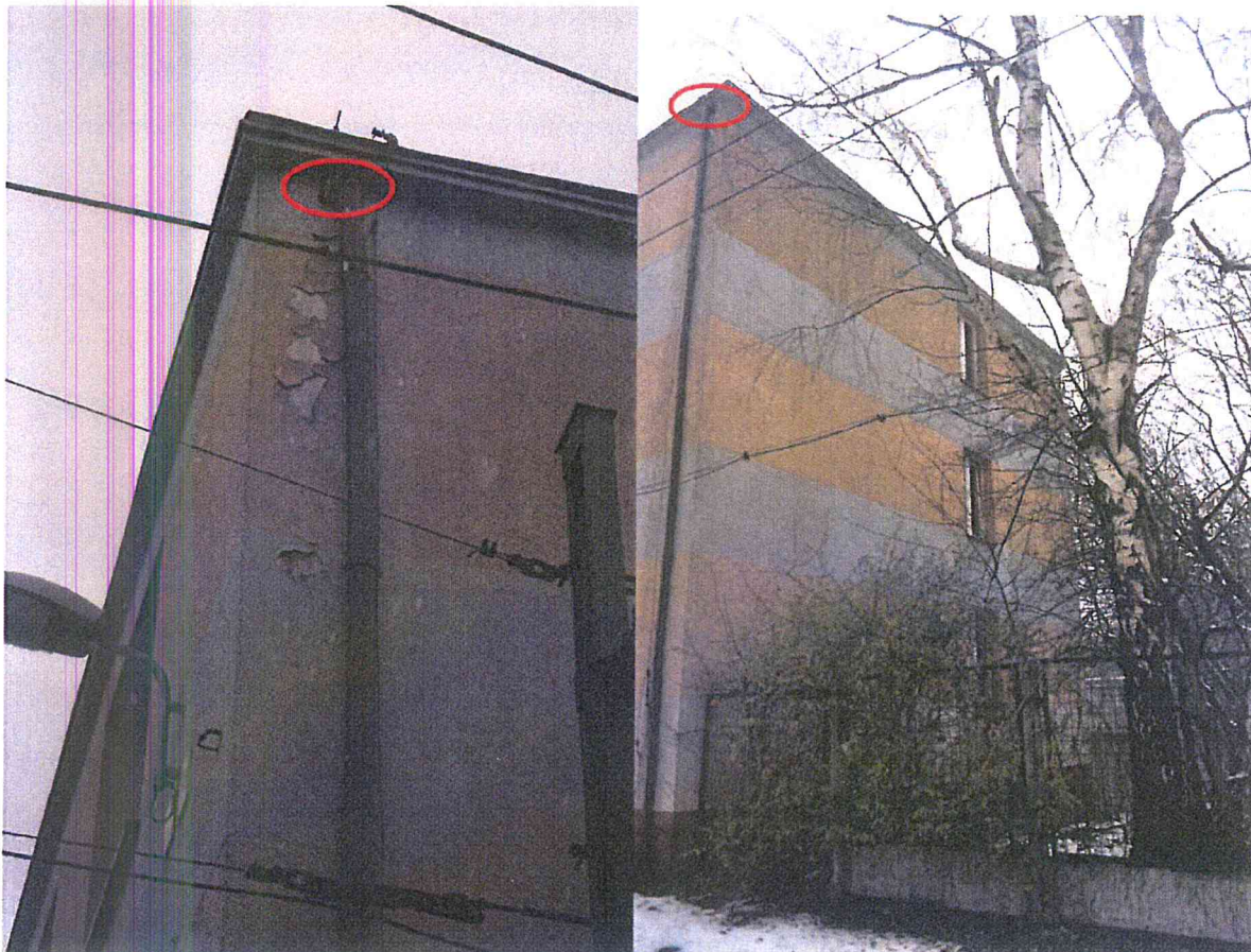
Fot. 3 i 4. Nisze – potencjalne miejsca lęgowe ptaków – w pobliżu połączenia rynien z budynkiem (podobne nisze stwierdzono przy wszystkich pionowych rynnach na budynku).
