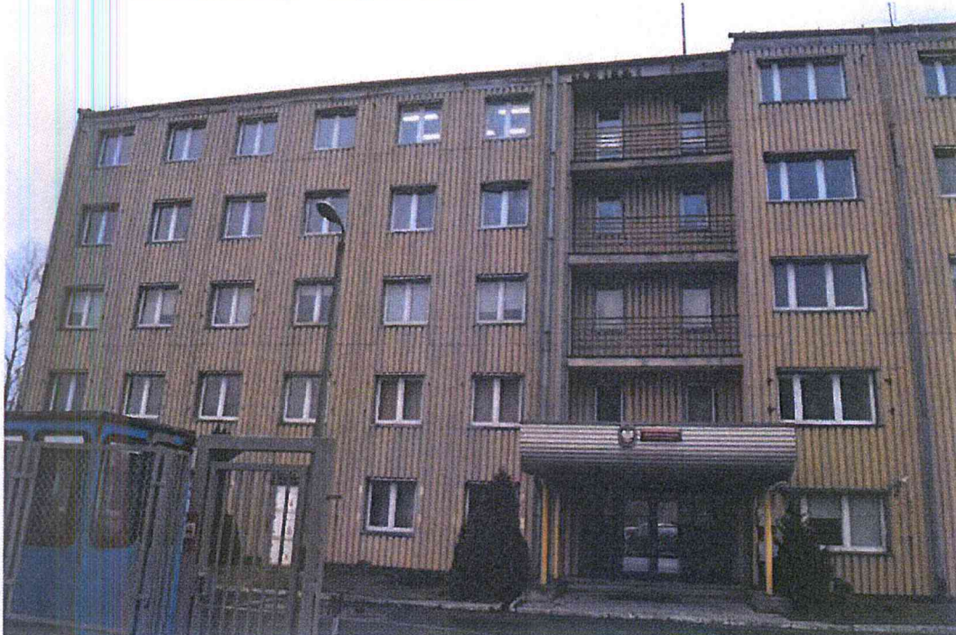
Fot. 1. Budynek Samodzielnego Pododdziału Prewencji Policji w Częstochowie widoczny zły części szczytowych ścian.
