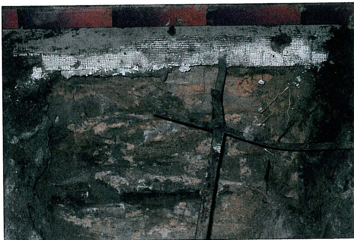
Fot. 4 – Górny fragment muru fundamentowego w miejscu odkrywki. Brak tynku i izolacji wodochronnej pionowej.
