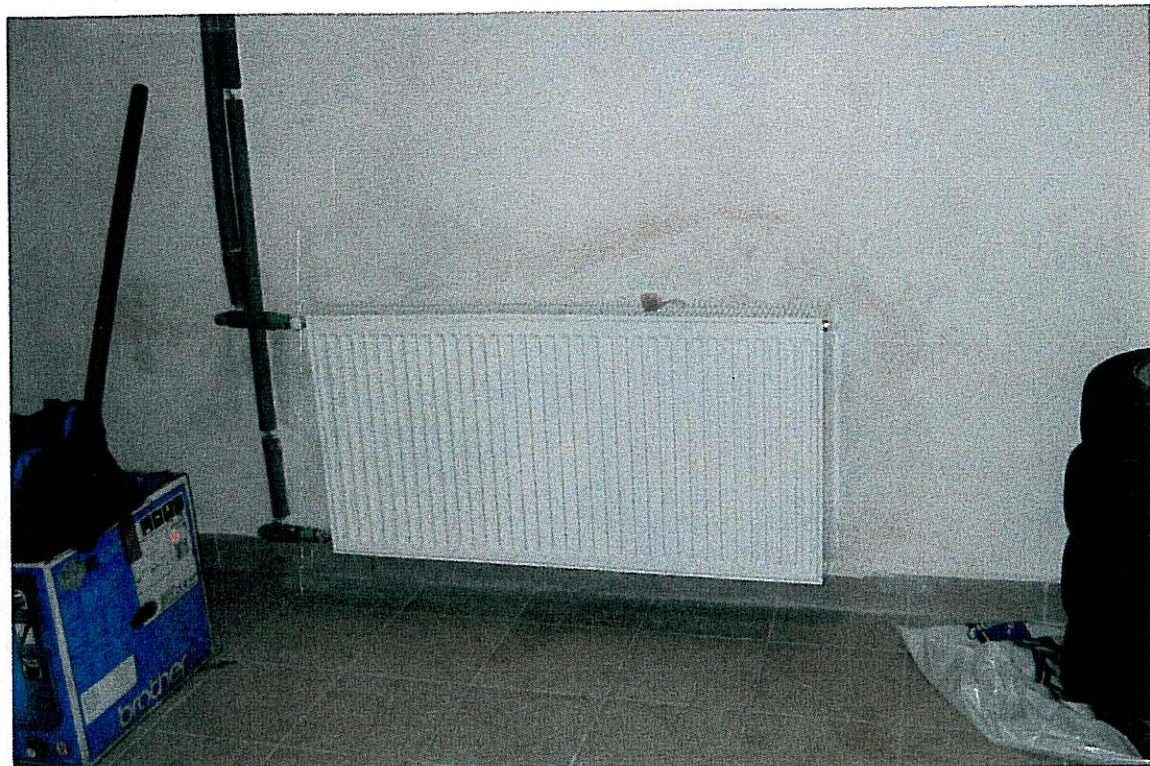
Fot. 1 – Przebarwienia na tynku zewnętrznej ściany zachodniej piwnicy
