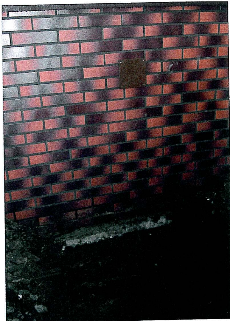
Fot. 3 Cokół budynku w elewacji południowej z widocznym murem fundamentowym z kamienia
