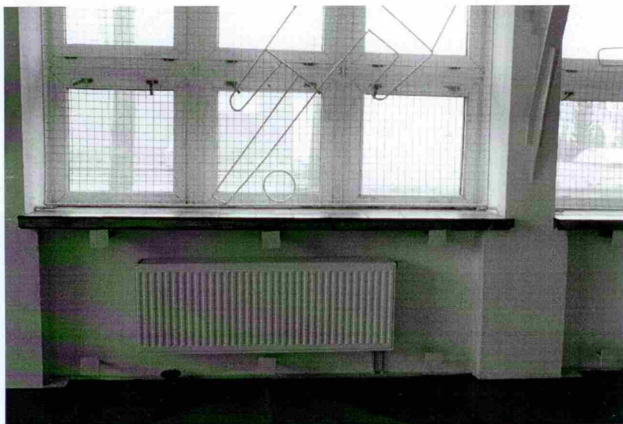
Foto nr 2. Ściana podokienna z grzejnikiem oraz elementy konstrukcji stalowej i żelbetowej - do obudowy.
