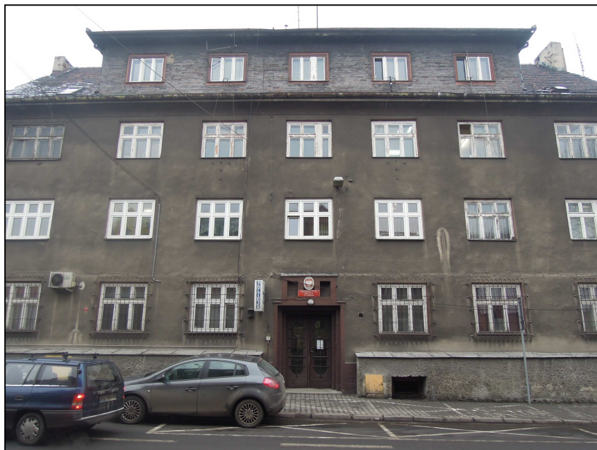
Elewacja wschodnia- od ul.D.Trocera- wejście główne
